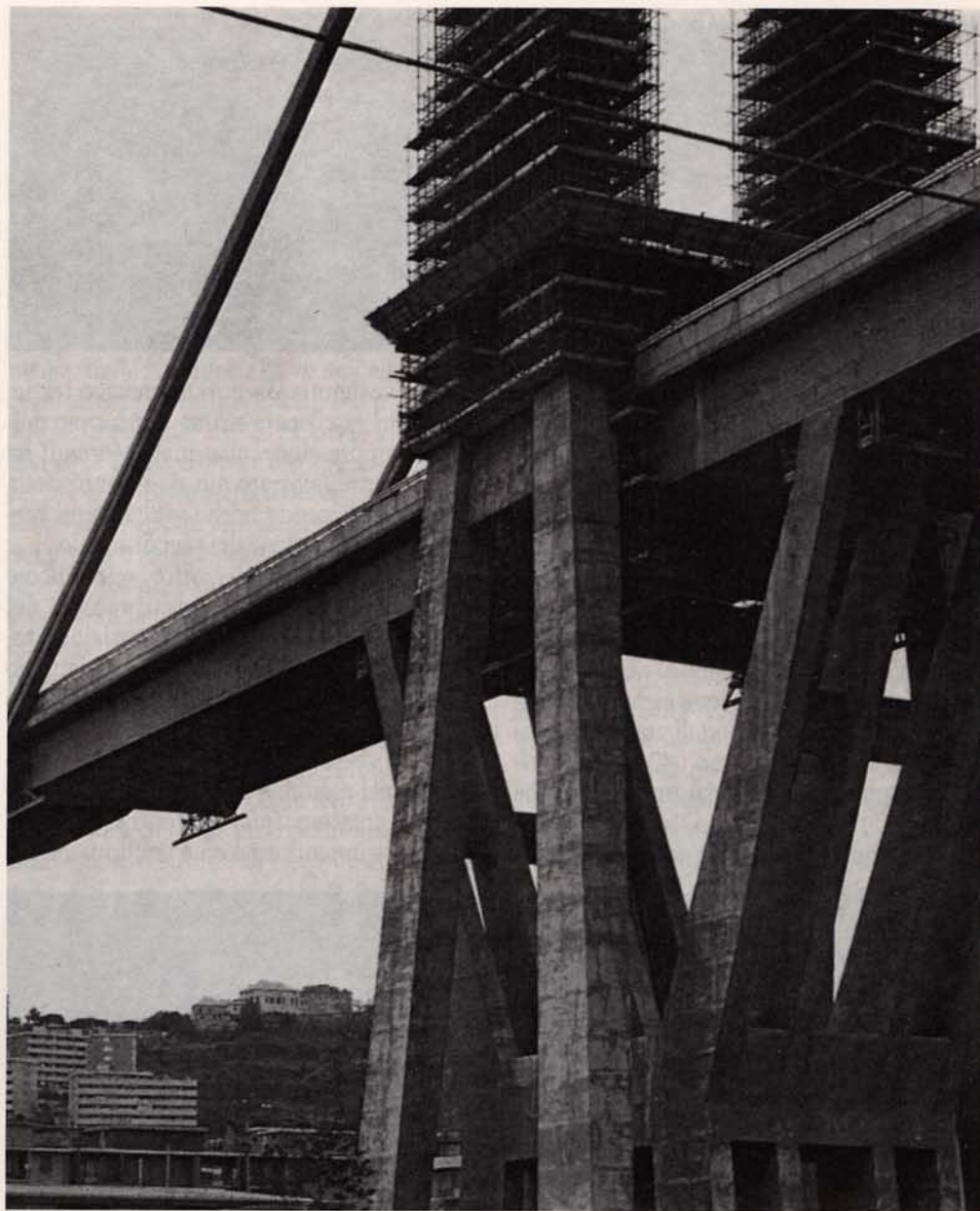
Il viadotto sul Polcevera e sul parco ferroviario, sull'autostrada Genova-Savona, nei pressi del capoluogo ligure, realizzato da Riccardo Morandi tra il 1960 e il 1964. Le immagini del servizio sono tratte da "Riccardo Morandi", Gangemi editore.
