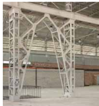
Sopra: particolare dei pilastri a struttura calcestruttata presenti all'interno dei capannoni; sotto: prospetto principale (foto ovest su Via Amendola) dei capannoni.
