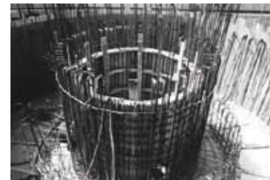
A destra: fase di costruzione del serbatoio, aprile '70; subito sopra: foto e sezione del serbatoio pensile a due livelli annesso al laboratorio di Ingegneria delle Acque.
