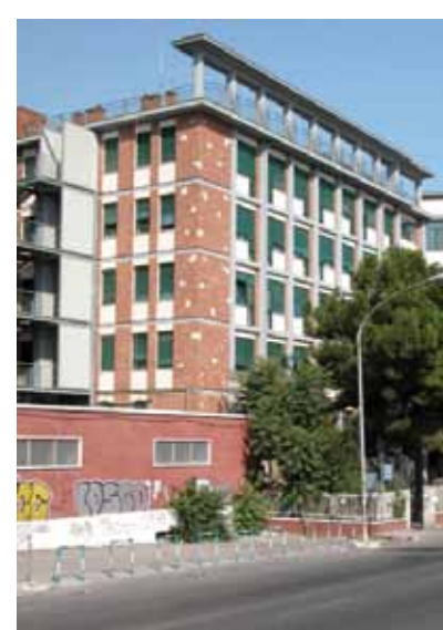
Sopra: pianta del piano terra dell'attuale Collegio Edisu Politecnico; a sinistra: fronte principale su via Amendola.
