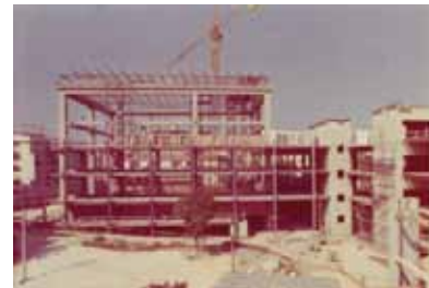
A sinistra: due immagini della Sala Alta Tensione in fase di costruzione, gennaio 1970.
