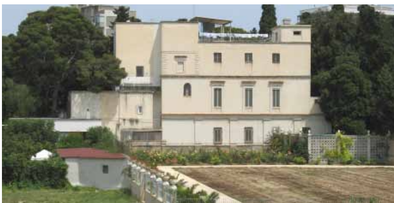
Sopra: due foto storiche che testimoniano l'assetto originario (foto Ficarelli); a destra: fotografia del prospetto sud interno all'area del Campus.
