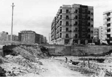
Da sinistra verso destra: vista aerea della città universitaria all'inizio degli anni '70; lavori di scavo per la realizzazione della Facoltà di Ingegneria, 1967; nella pagina accanto: planimetria generale del progetto "Teurium" redatto da Piero Masini, per la risistemazione urbanistica del Campus.
