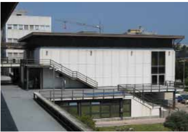
A sinistra: Aula magna Attilio Altè della Facoltà di Ingegneria; a destra Nuova sede della Facoltà di Architettura.
