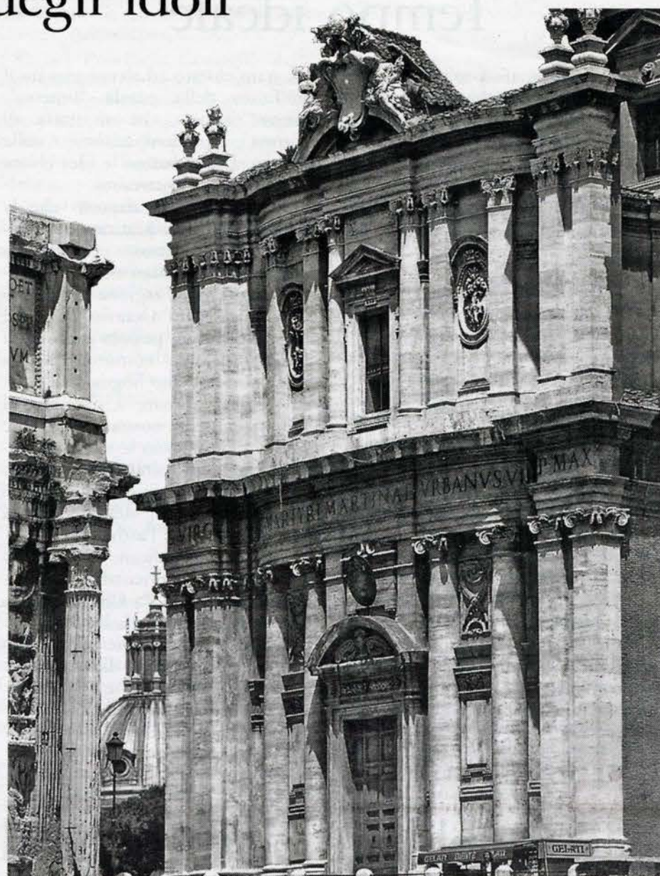
La facciata della chiesa dei Santi Luca e Martina
