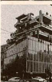
32 V., F. e L. Passarelli Edificio polifunzionale 1963-65 Via Campania, Via Romagna
