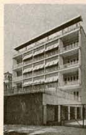
36 M. Ridolfi, W. Frankl Palazzina Rea 1934-36 Viale di Villa Massimo 39
