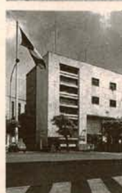
49 G. Samonà Palazzo delle Poste al quartiere Appio 1933-35 Via Taranto
