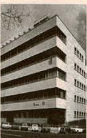
20 M. De Renzi Palazzina Furmanik 1941-42 Lungotevere Flaminio 18
