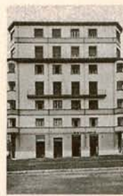
33 A. Di Castro Edificio d'abitazione 1931 Via Catania 26
