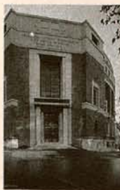
26 M. Piacentini, G. Vaccaro Ministero dell'industria, artigianato e commercio (già Ministero delle corporazioni) 1927 Via Veneto 33
