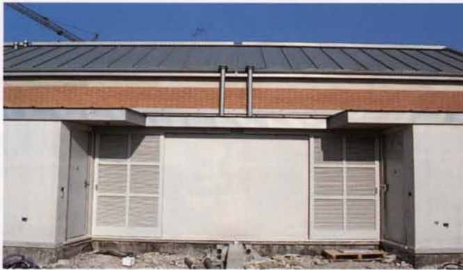
Immagini d'insieme e dettagli costruttivi degli edifici realizzati (sub-comparto 6)
