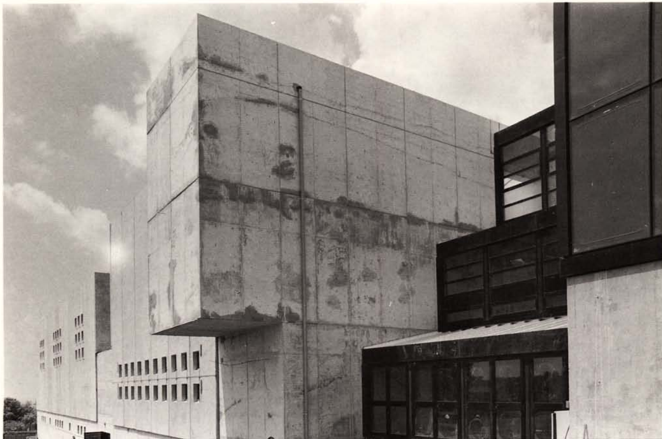
Particolare dell'atrio e del nodo scala centrale
