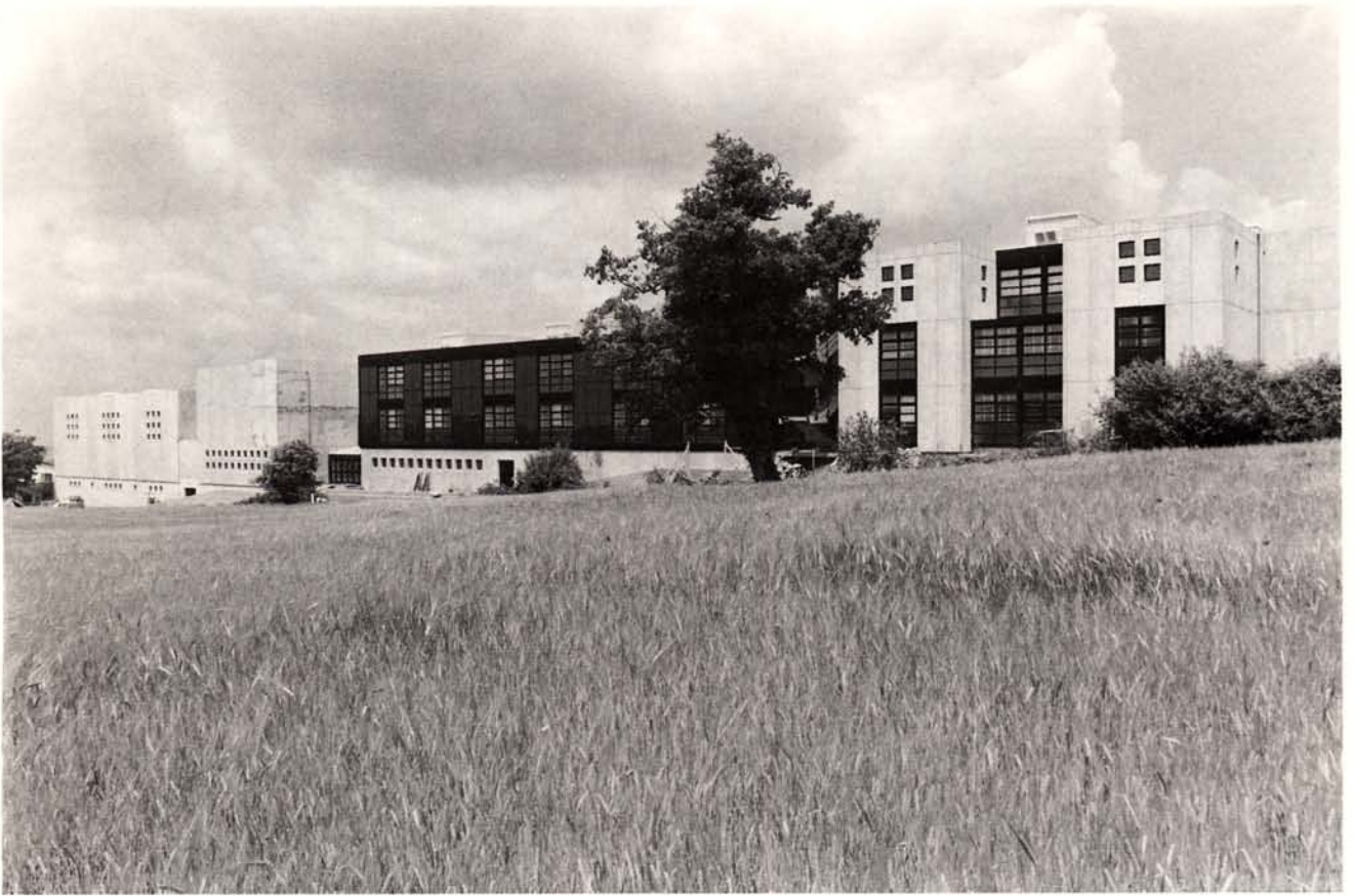
Fronte sud del complesso scolastico
