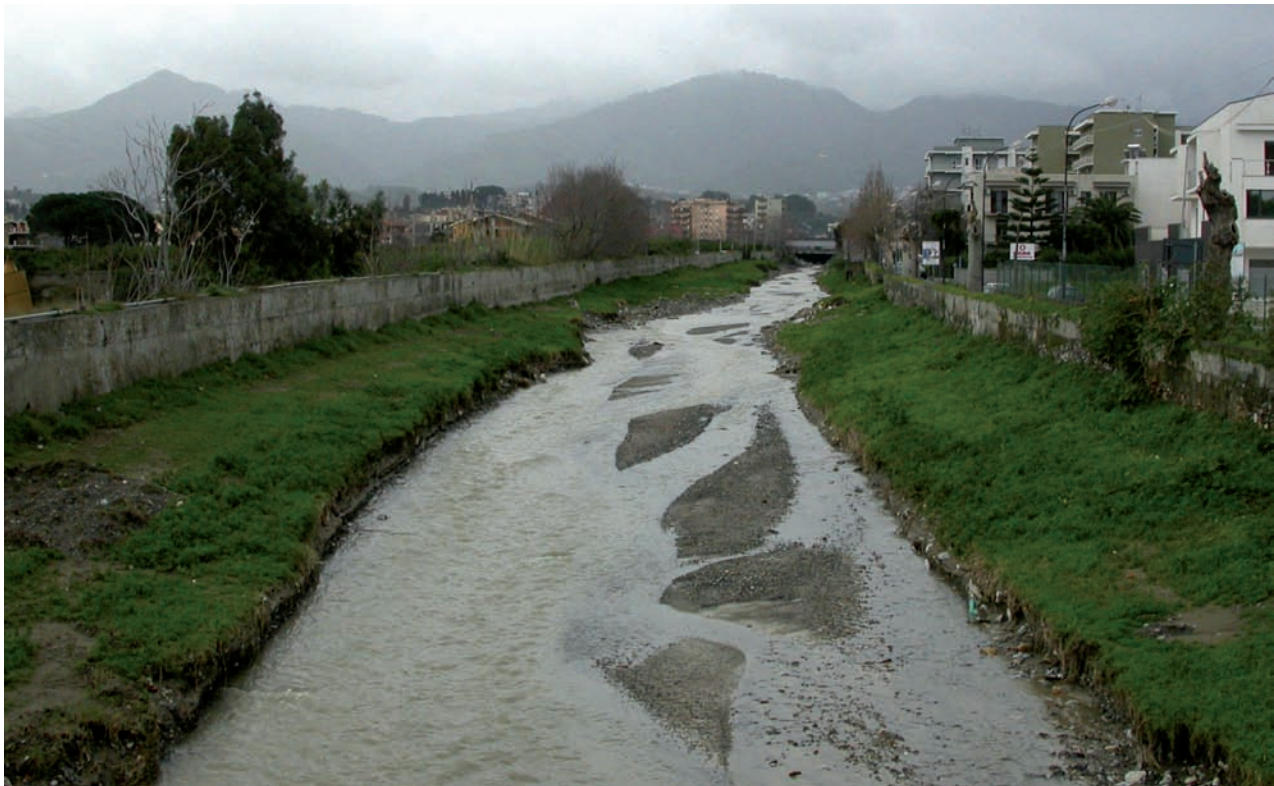
4_Veduta del Torrente Longano.
