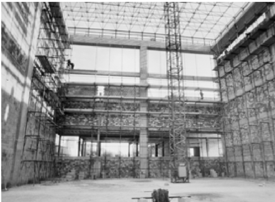
Interno della Sala Alta Tensione in fase di costruzione, gennaio 1970;
