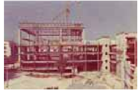
Fotografia della Sala Alta Tensione in fase di costruzione, gennaio 1970
