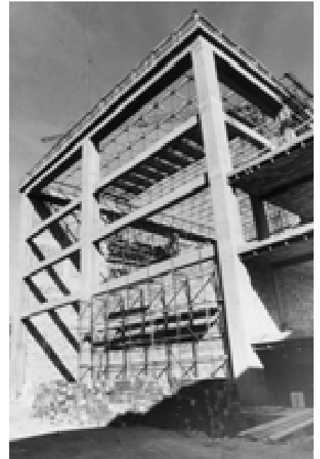
Fotografia della Sala Alta Tensione in fase di costruzione, gennaio 1970
